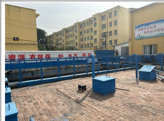
生活污水处理站
