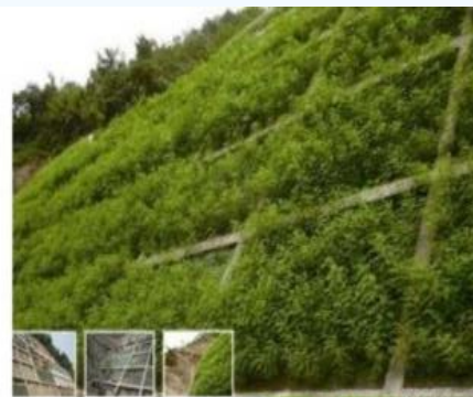
锚杆框架梁+生态袋绿化
